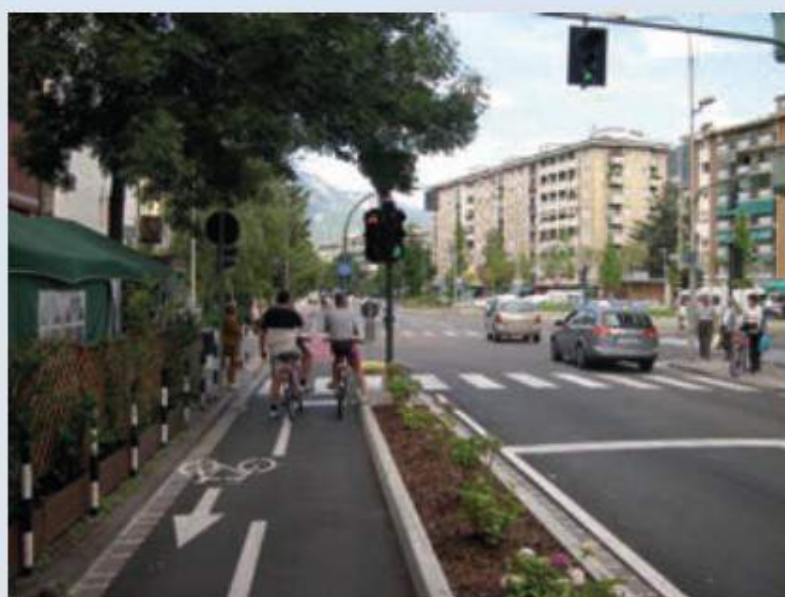
BOLZANO. ELEMENTO SEPARATORE REALIZZATO CON DOPPIO CORDOLO E RIEMPIMENTO VERDE.
